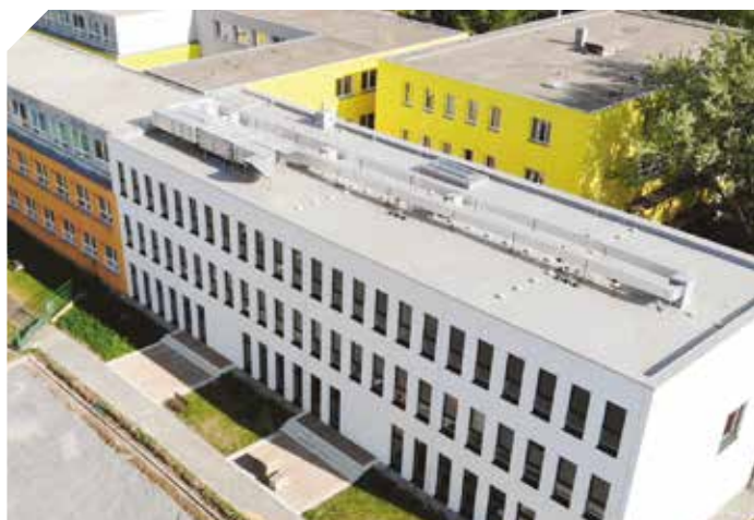
Nový pavilon ZŠ Novoborská
