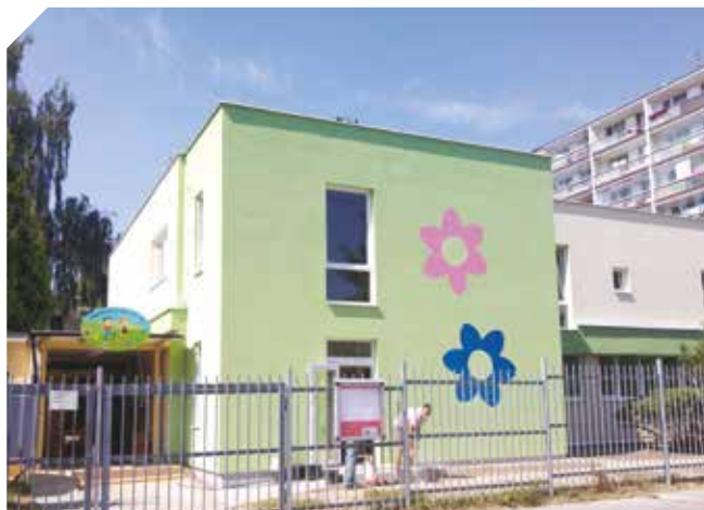
Nástavba Mateřské školy Veltruská rozšířila její kapacitu o 26 míst
