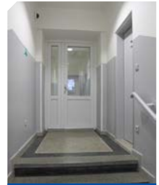
Vchod do vysočanské služebny Policie ČR po rekonstrukci...
