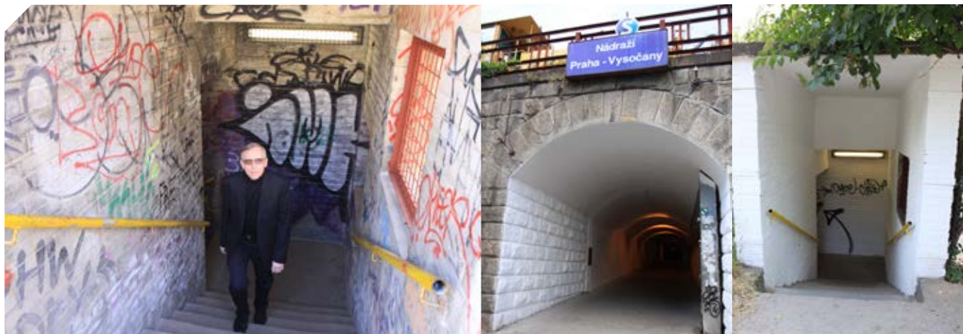
Připravujeme tolik potřebnou rekonstrukci Vysočanského nádraží. Prvním, alespoň kosmetickým, krokem bylo vymalování podchodu pod kolejemi.
