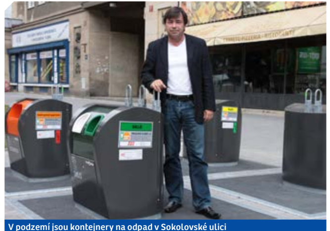
V podzemí jsou kontejnery na odpad v Sokolovské ulici
